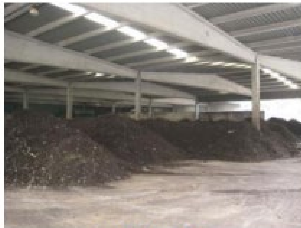
Maduración en pilas
