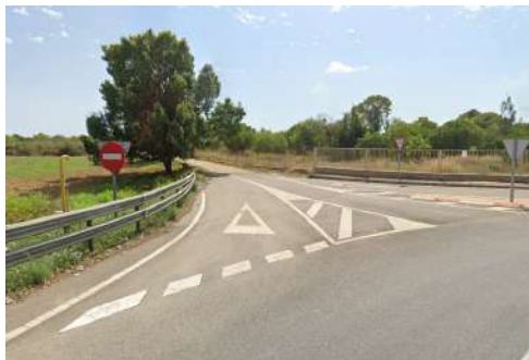
Figura 91: Accés actual a la rotonda de la C-31 des de la ctra. Bcn-Tgn
