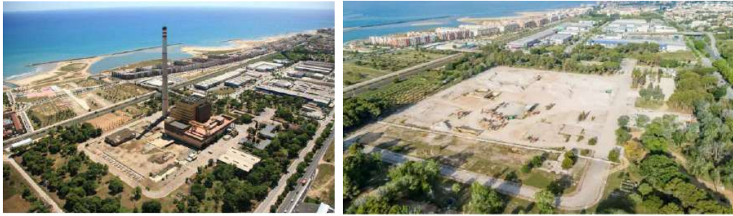
Imatge 2: instal·lacions de la Central Tèrmica en funcionament. Imatge 2: Estat actual dels sòls
